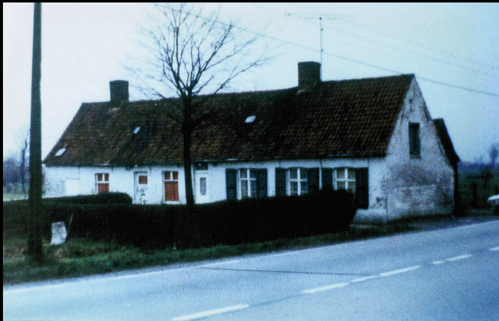
Oude huizen in 1972 langs de Bruggesteenweg.
